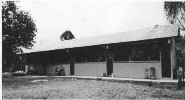
Foto1: Sustitución de lámina, por lámina troquelada Aluzin calibre 26.
