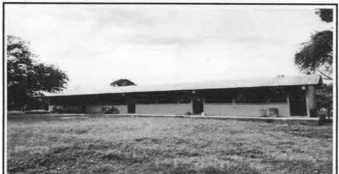
Foto 6: Desinstalación de lámina existente.
