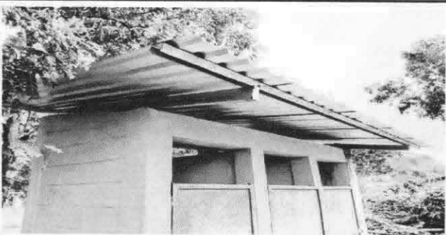
Foto 9: Sustitución de estructura de soporte de madera por metal, baños.
