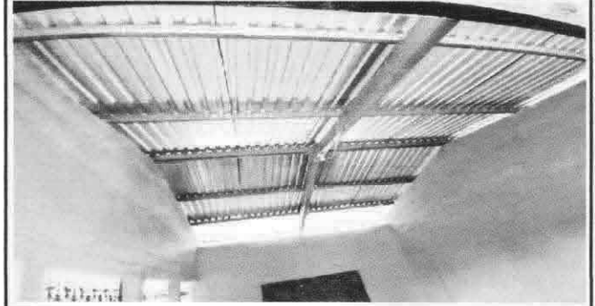
Foto 2: Mantenimiento de estructura de soporte de metal.
